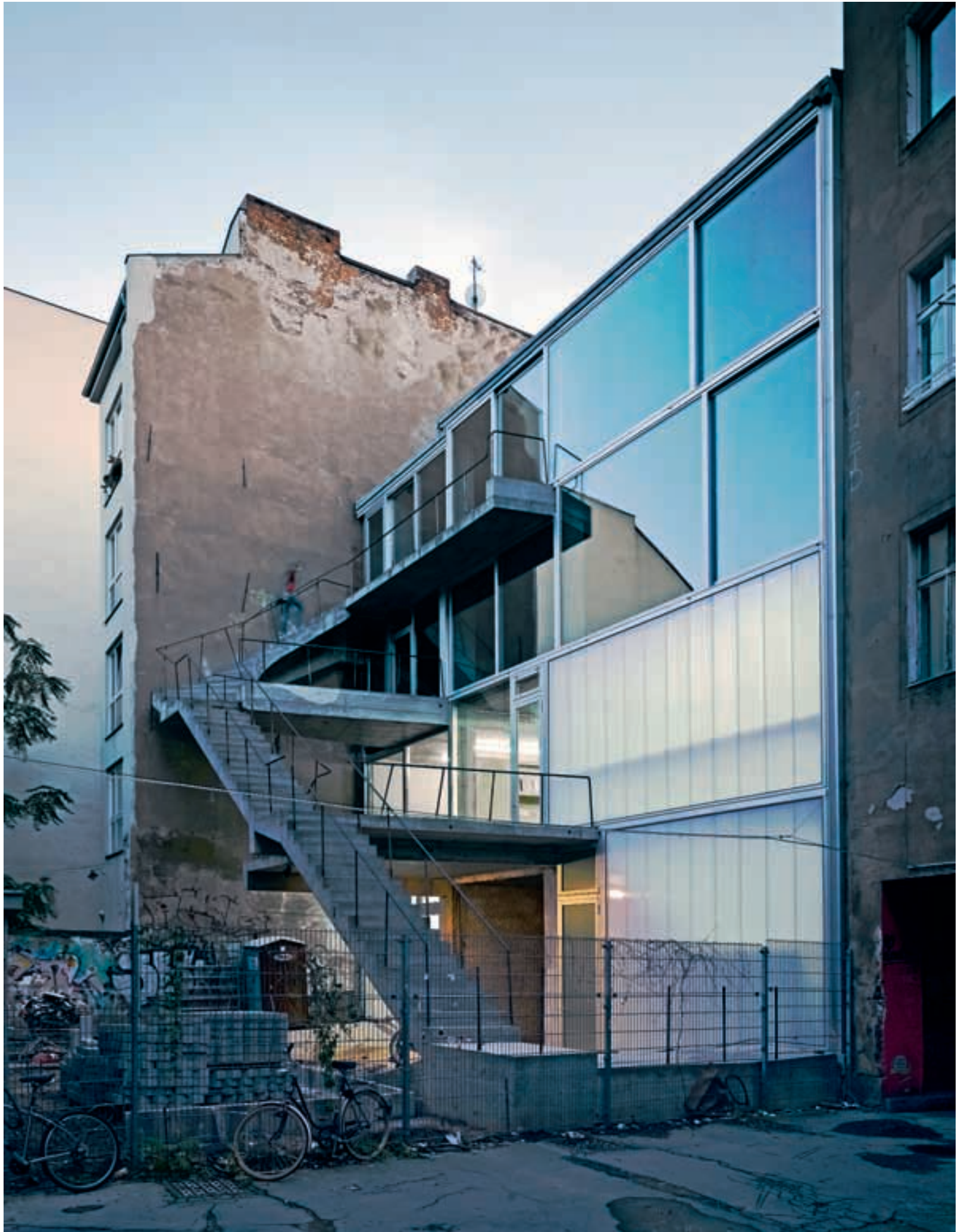
Hoffassade mit Außentreppe. Foto: Michael Reisch
