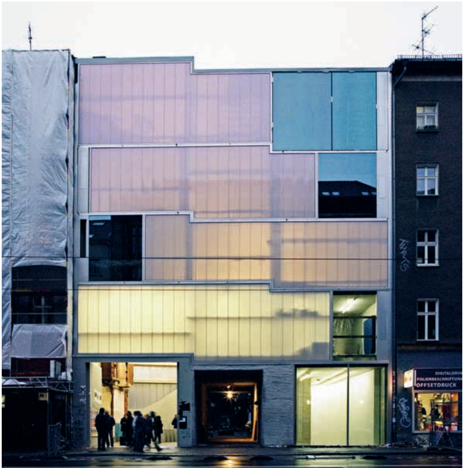
Ansicht Brunnenstraße. Die Versprünge in der Fassade vermitteln zwischen den unterschiedlich hohen Geschossdecken der angrenzenden Nachbarhäuser. Foto: Clemens Vogel
